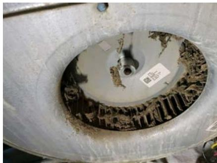
Figure 6 - Soufflante nécessitant un bon nettoyage.
