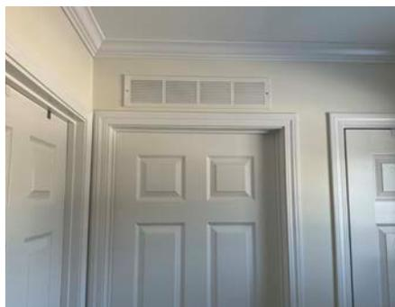
Figure 8 - La grille d'imposte joue un rôle déterminant dans la circulation d'air.
