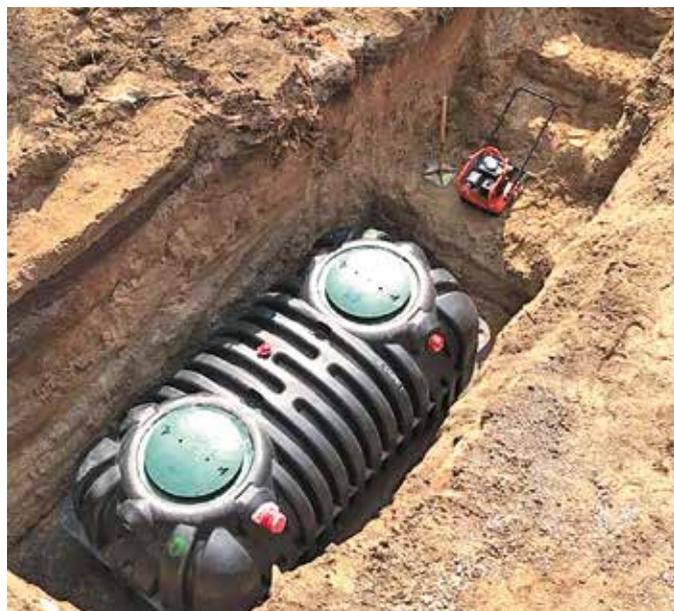
La dimension des réservoirs de stockage de l'eau de pluie varie d'une centaine de litres à des dizaines de milliers de litres, et ces derniers peuvent être installés sur le sol ou dans le sol (comme illustré ici).
