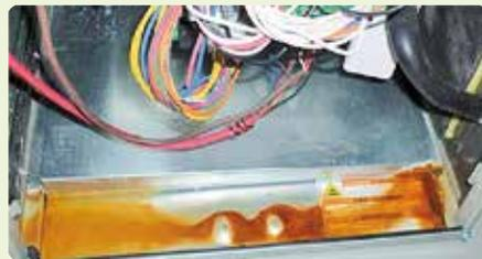
Des condensats acides de fournaise qui fuient détrempent les tapis et font rouiller le métal.
