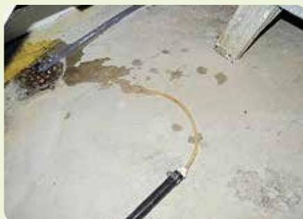
À quoi avez-vous pensé? Le tuyau d'évacuation a été réduit de 3/4 à 1/2 po. Du polypropylène souple a été utilisé, lequel peut facilement être plié, écrasé et bloqué. Pour finir, un tuyau de 1/4 po se rend sur le couvercle de l'avaloir de sol.
