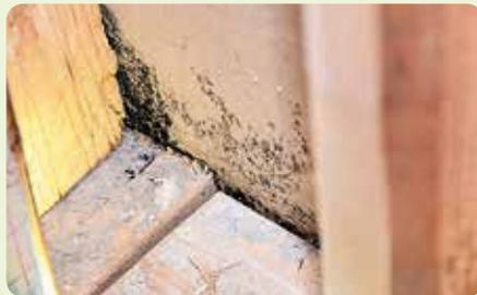
De l'eau qui dégoutte d'un serpentin d'évaporateur gelé finit par faire déborder le bac de retenue, générant une inondation mineure. Ici, l'eau a coulé dans une cloison sèche avoisinante, y provoquant la formation de moisissures noires. Aussi, le tuyau d'évacuation du serpentin termine sa course dans une ouverture du plancher en béton – je ne recommande pas cette pratique.
