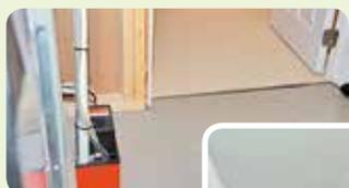
Les systèmes de CVC utilisant une pompe à condensats installée dans un sous-sol fini, dans un grenier ou à tout autre endroit susceptible de causer des dommages matériels requièrent une protection supplémentaire. Les pompes à condensats doivent être équipées d'un flotteur de sécurité (fil jaune) et les unités au plafond doivent comporter des bacs de retenue pouvant s'évacuer avec une conduite séparée.
