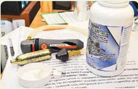
Utilisez un algicide dans les bacs de retenue et les pompes à condensats pour empêcher l'accumulation de boue. Soufflez les conduites d'évacuation chaque année.
