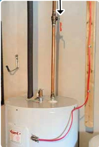
Le dispositif IdO actionne le robinet sur le chauffe-eau ou sur la conduite d'eau principale jusqu'à ce qu'il soit fermé. Des robinets avec un dispositif IdO interne sont également offerts à un coût plus élevé.
