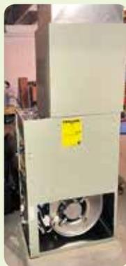
Les fournaises, chauffe-eau, chaudières et appareils de traitement d'air devraient être installés sur une base de béton solide, soulevée d'environ deux pouces (50 mm) au-dessus du sol, les protégeant ainsi d'une inondation mineure.
