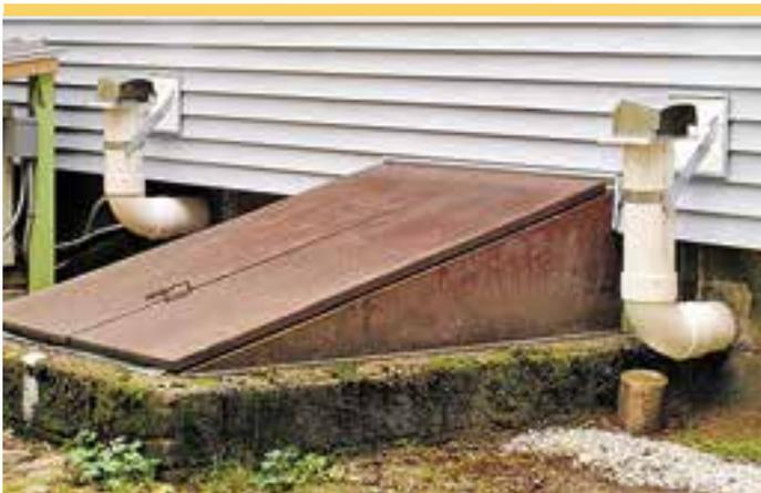
**Il est temps de raccorder un ensemble élévateur concentrique à la sortie du VRC, ou mieux encore, un raccord d'extrémité vertical dans une fausse cheminée.**
