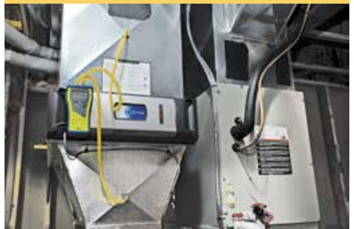
**Installer les boîtiers de filtres à air horizontalement dans la mesure du possible, afin d'en améliorer l'entretien et éviter devoir installer des déflecteurs dans le conduit de retour d'air. L'installation d'un filtre à ΔP initiale faible signifie que moins d'énergie sera requise pour déplacer l'air à travers le système.**
